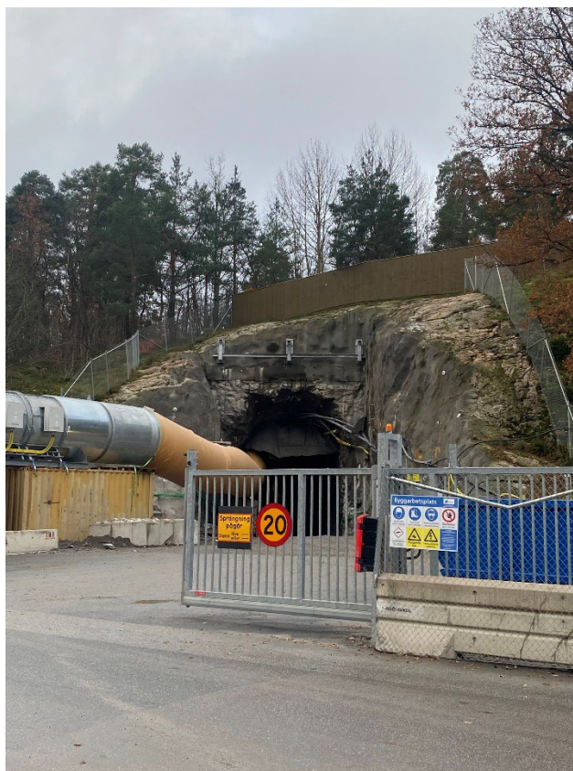
Figur 3. Arbetstunnel vid Dalvägen i projekt Arenastaden.
